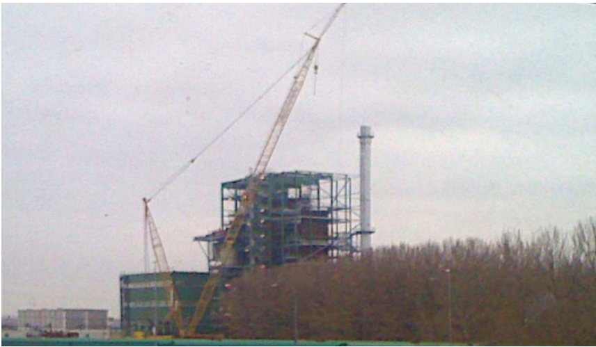
Planta de Valorización Energética en construcción.
